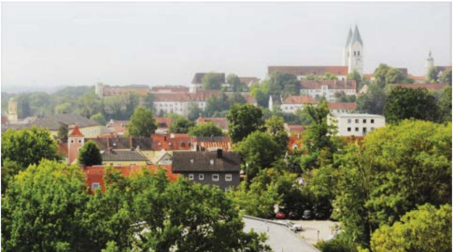
Die ehemalige Stadtmauer vom Krankenhaus aus gesehen
