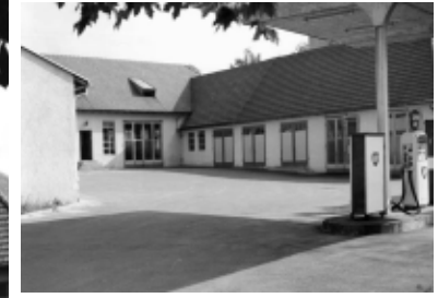
Oben: Werkstatt und Garagen mit Tankstelle
