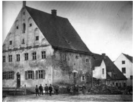
Das Seelnonnenhaus vor dem Abbruch.
