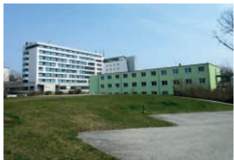
Blick v. Westen, vorne Rettungshubschrauber-Platz
