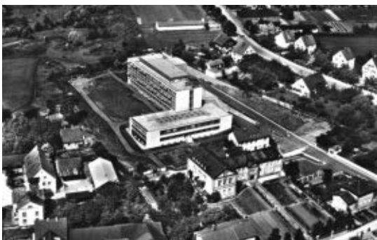
Kreiskrankenhaus (hinten) und ehem. Distriktkrankenhaus (vorne). Oben die amerikanische Kirche, heute Hofmiller Gymnasium.
