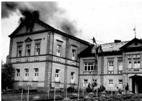
Brand im ehem. Kreiskrankenhaus Freising am 25. Mai 1956.
