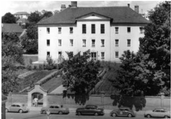
Städtisches Krankenhaus noch mit Mauer zur Kammergassel
