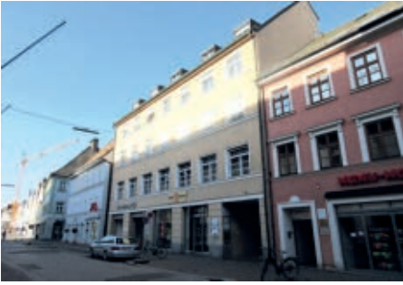
Das ehem. AOK Gebäude, Obere Hauptstraße, heute.
