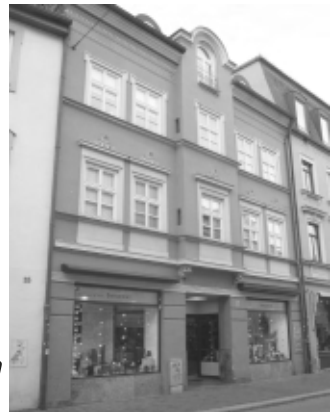
Rechts: Heute (2015) befinden sich in dem Gebäude zwei Schuhgeschäfte.
