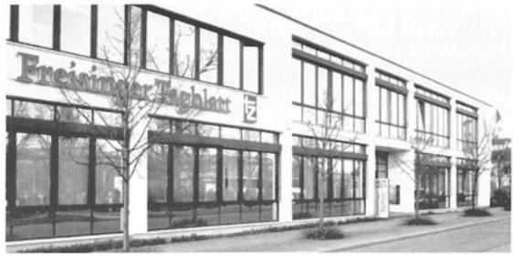
Das moderne neue Verlagsgebäude an der Münchner Straße
