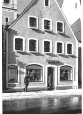
rechts: nach späterem Umzug in die Obere Hauptstraße, befindet sich heute dort ein Optikerladen.
