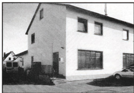
Das kleine Foto oben Mitte zeigt den Firmengründer Karl Schlegl beim Gespräch mit seinen Mitarbeitern. Darunter das Firmengebäude an der Hallbergmooser Str. 27
