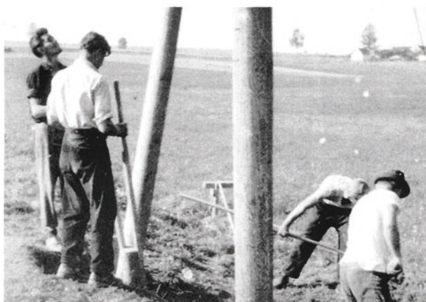
Die Mannschaft der Firma Daimer beim Freileitungsbau für die Deutsche Post.
