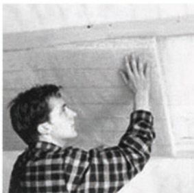
Untersparrendämmung
