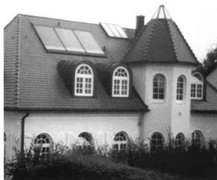
Ebenfalls ein Vorzeigestück, das Dach der Villa Dr. Plahl in Freising
