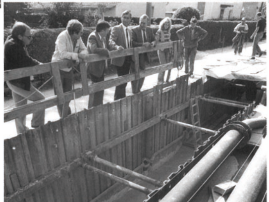
Auch im Kanalbau war die Firma Birnbeck aktiv. Das Bild zeigt eine Kanalbaustelle im Jahre 1976
