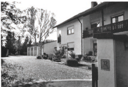
Abbildung links Wohn und Geschäftshaus von Franz Großkopf
